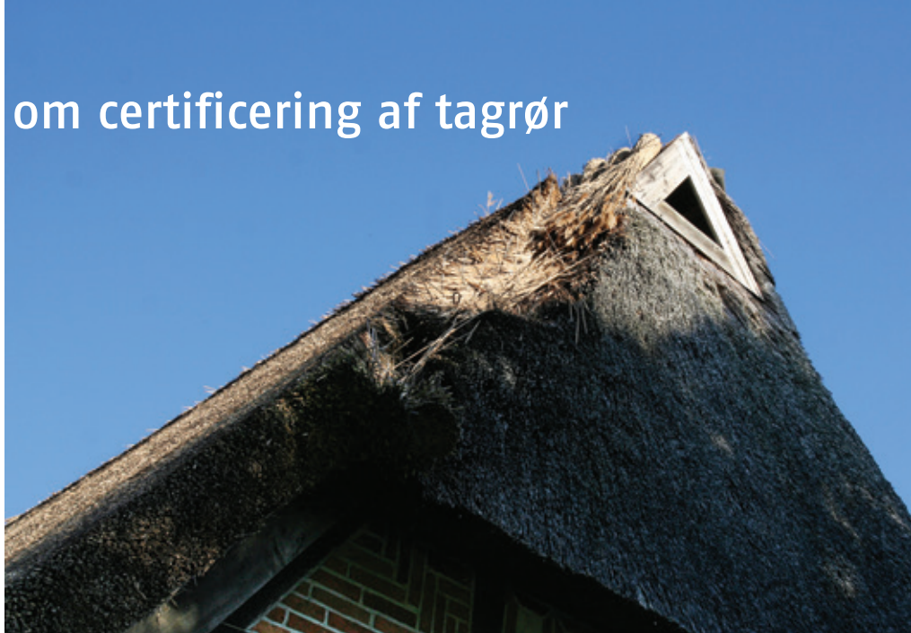
Et nytækket tag hvor også gavlen skal tækkes om. Læg mærke til stråhældningen på tagfladen
