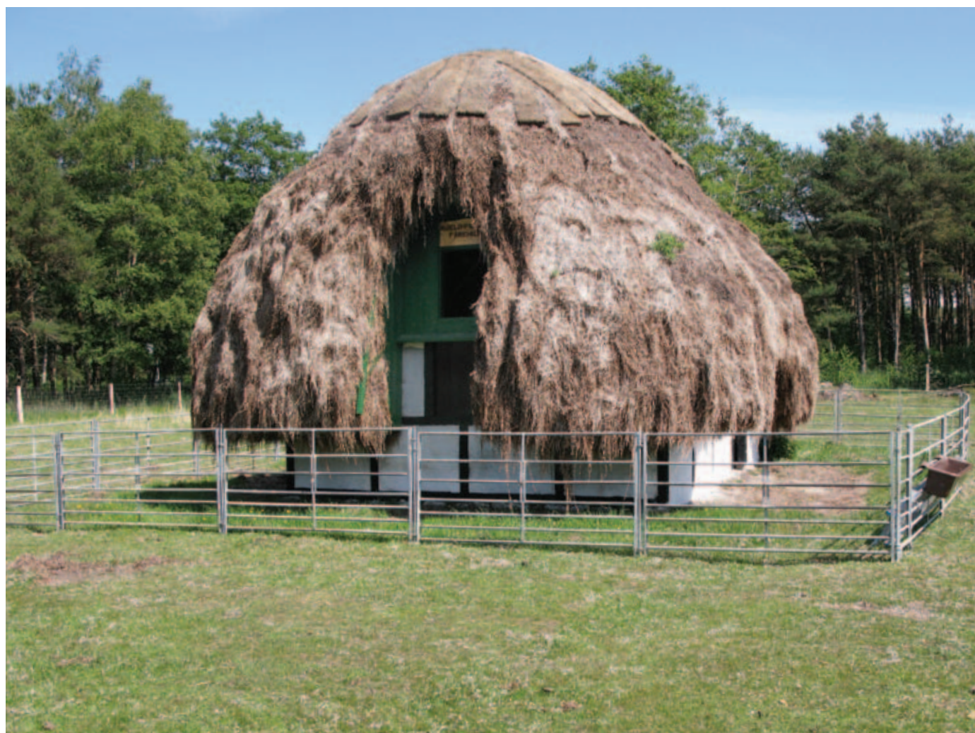
Kjeld Posts 25 m 2 fåre- og gåsehus, hvor der blev lagt syv tons tang på taget
