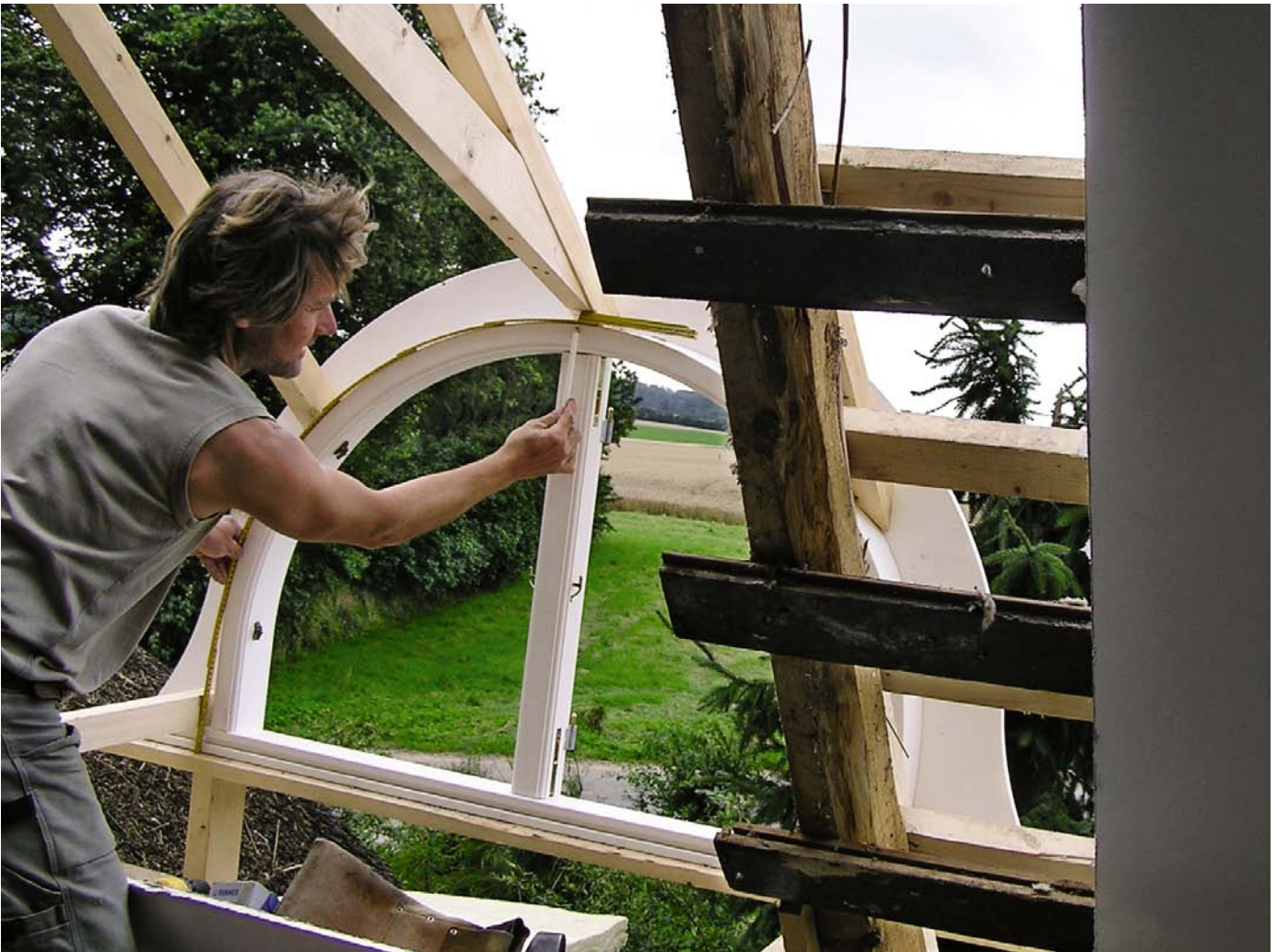
Opmåling til afskæring af gipsbue
