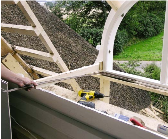
Klargøring til montering af gipsbuer
