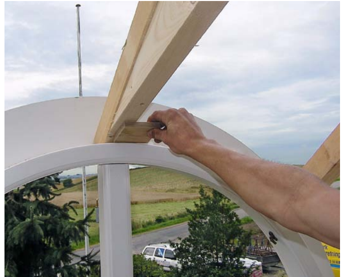
Prøveklods sikrer at der er plads til gipsbue
