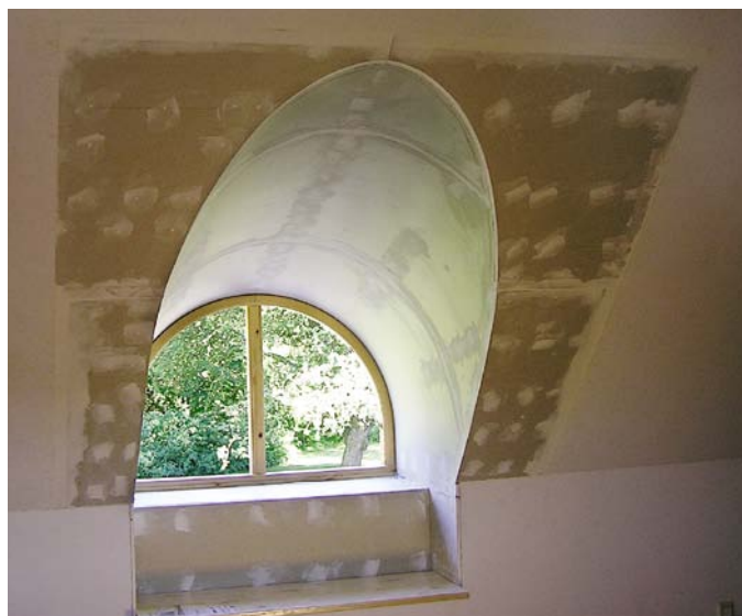
Færdig afslutning af gipsbue i gl. beklædning
