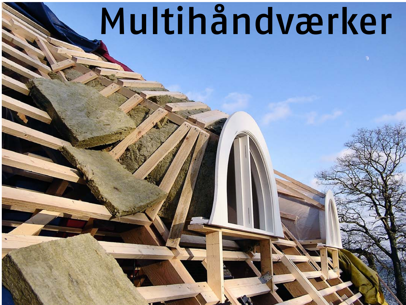
Isolering af kvist inden tækning
