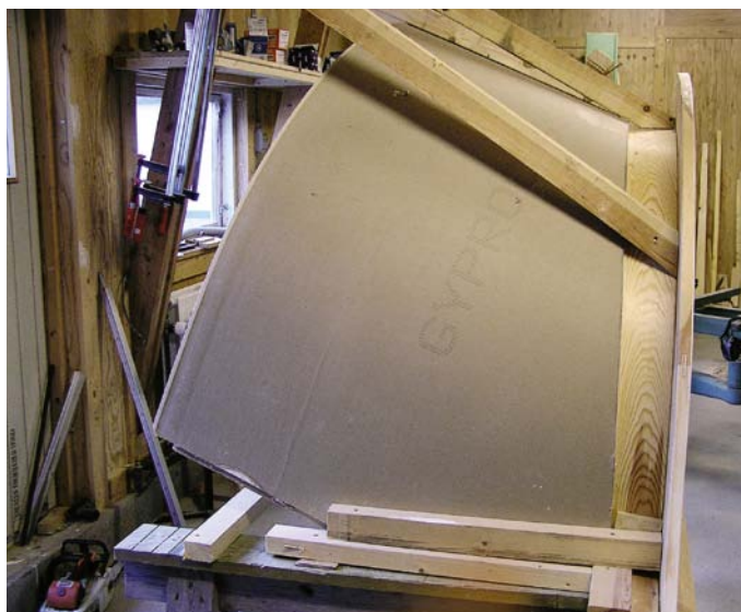
Opstilling af gipsbue på kvistvindue i værkstedet
