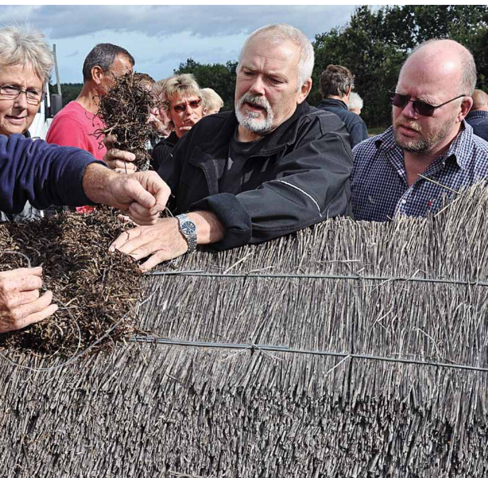
instrueres af tækkemand Henning Johansen fra Læsø i oplægning af tang mønning. var inviteret til at fortælle om udenlands arbejdskraft
