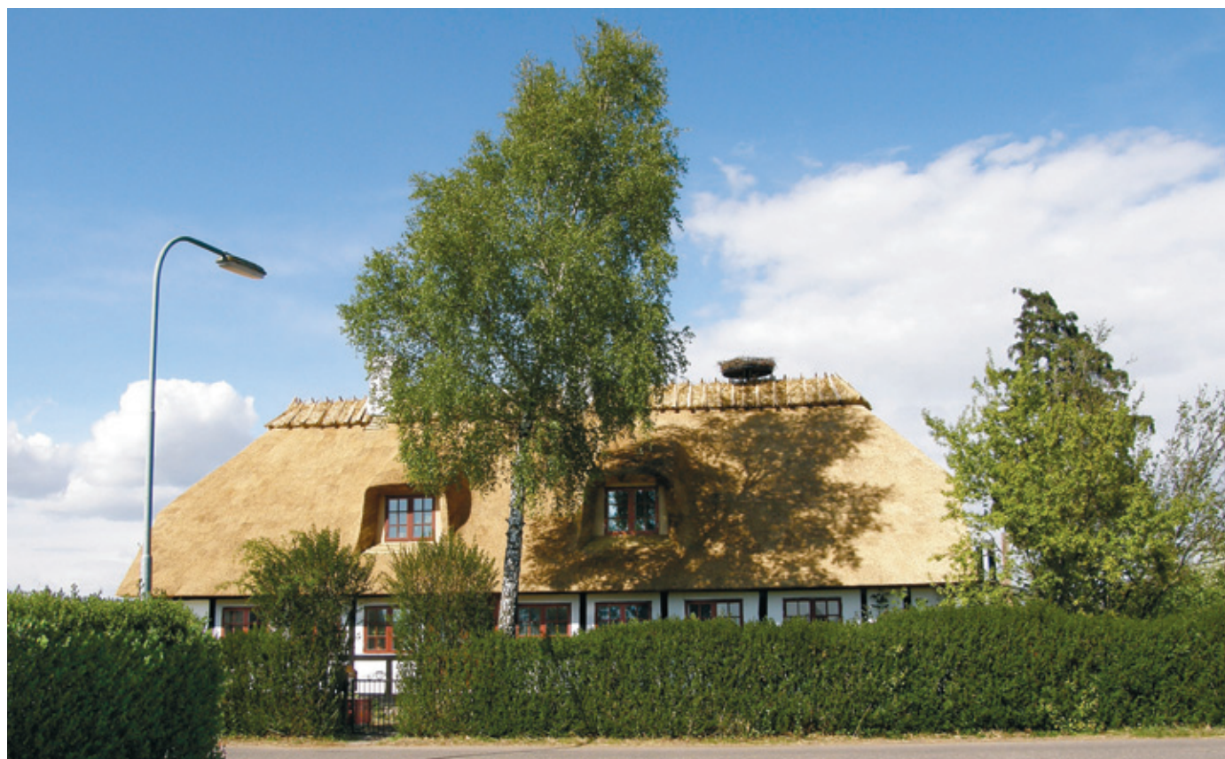
Nyt stråtag – og ny storkerede på huset i Thurø. Sydfynsk Håndværk A/S har totalrenoveret det ude og inde med tække-, tømrer-, murer-, VVS- og malerentreprise
