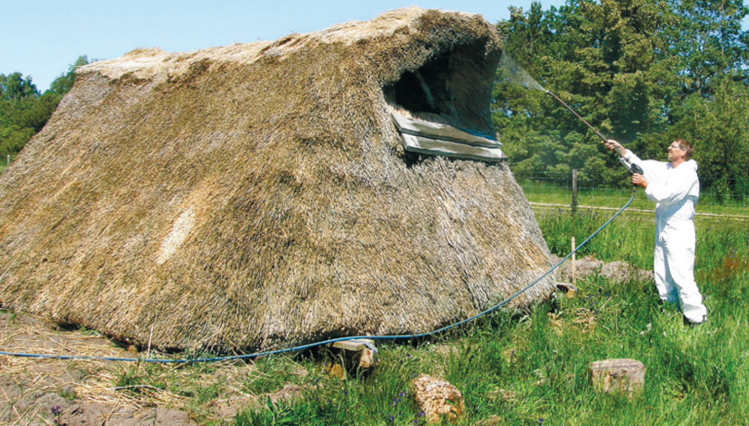
Henrik Henriksen på arbejde med Magma brandimprægnering af et grubehus ved Sebbersund i Nibe. Der bruges åbent bål under stråtaget
