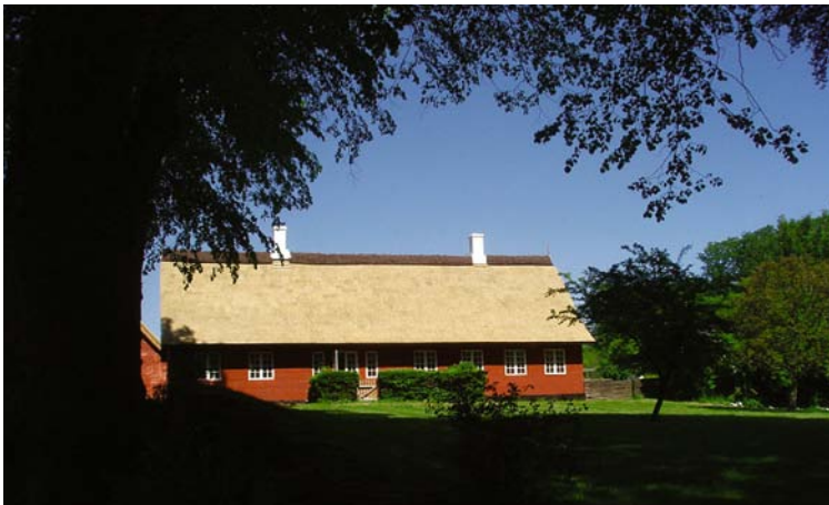
Kolle Kilde Hus er et eksempel på noget af det arbejde, som Joy og Søren Finsen udfører for Statsskovsdistriktet. Her er brugt svenske rør
