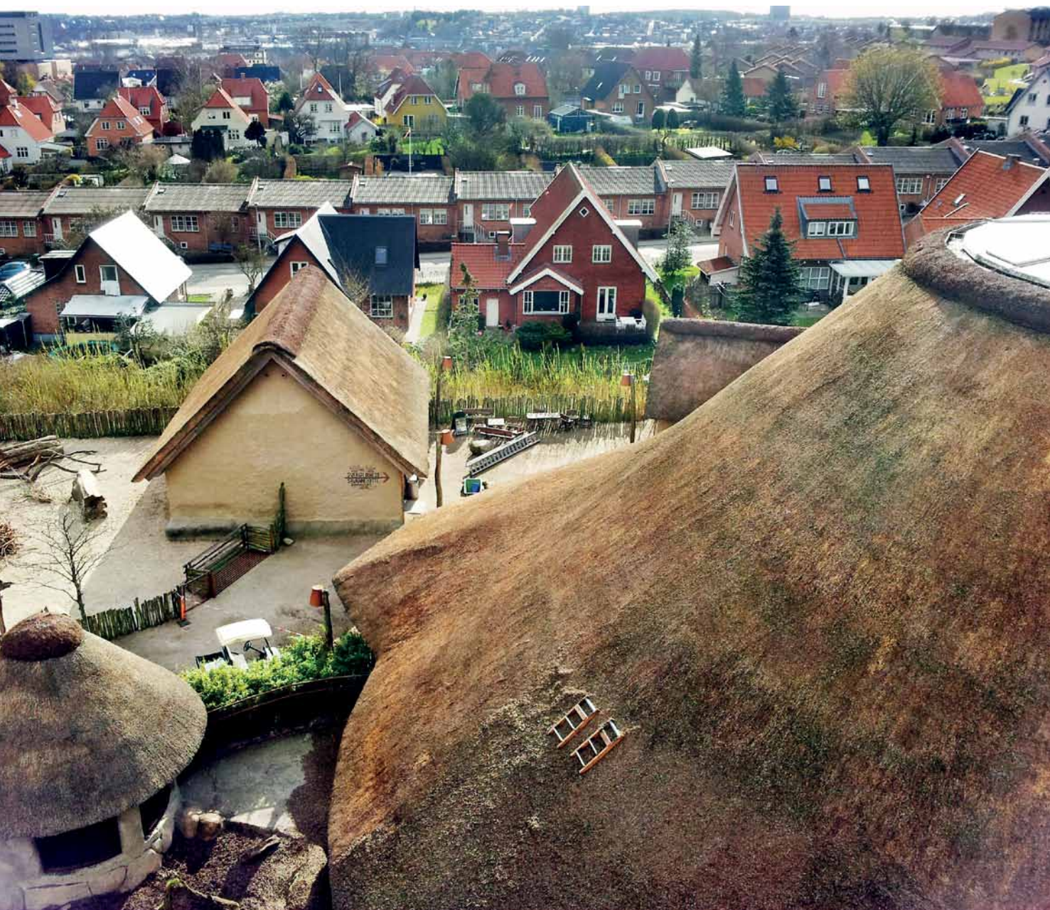
Alternativet til stråtaget havde været spåntræ, men nu er levetiden af stråtaget i stedet blevet forlænget
