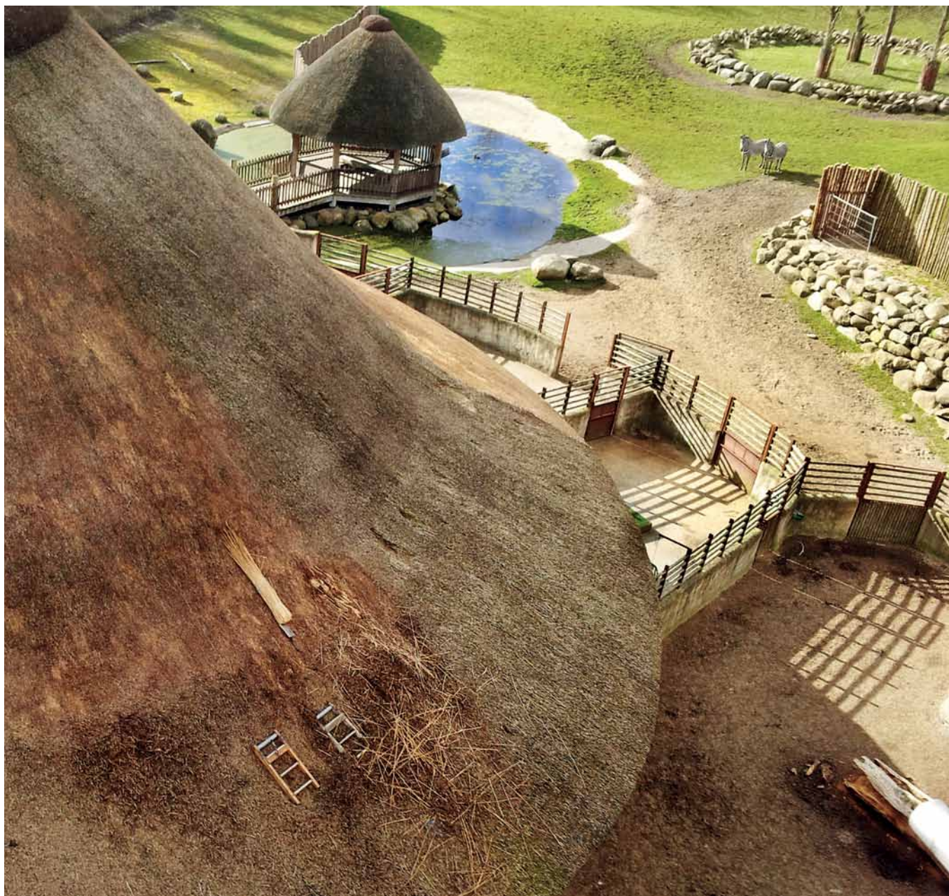
Hovedhuset i Den Afrikanske Landsby er et af i alt seks huse, som har undergået en reparation
