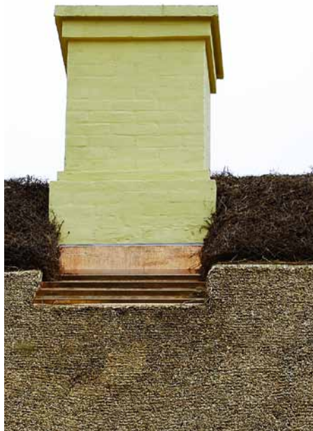
John Briston bruger også kobber. Her er det på vandbrædderne ved skorstenen
