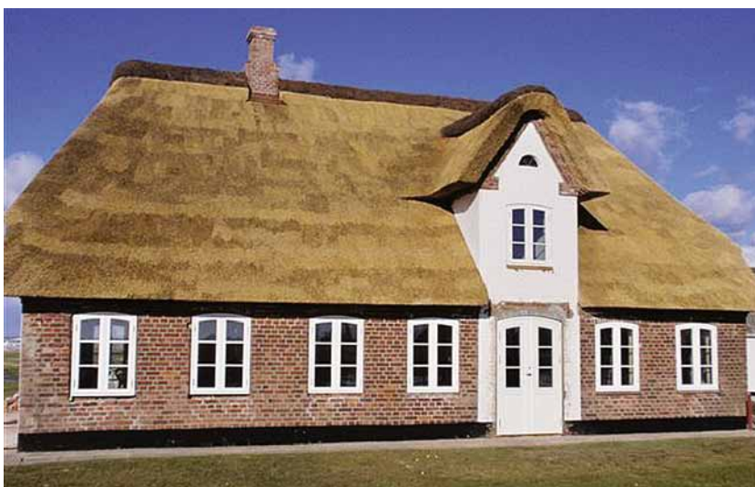
Før under og efter tækning. Huset har fået værdigheden tilbage efter mange år med et livløst eternittag
