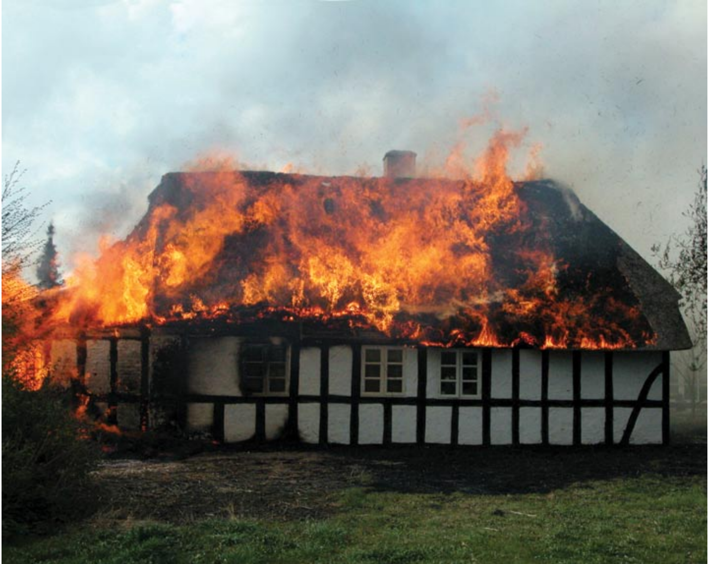
Skorstensgnister og ingen brandsikring
