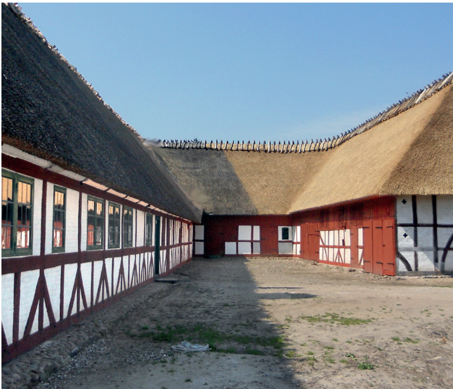
En sammenligning af dette foto med fotografiet fra før restaureringsarbejdet gik i gang, fortæller alt om den enorme opgave, det har været at føre Jollmands Gaard tilbage til fordums pragt
