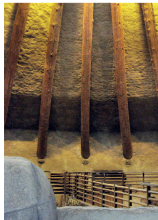
Bygningen set inde fra
