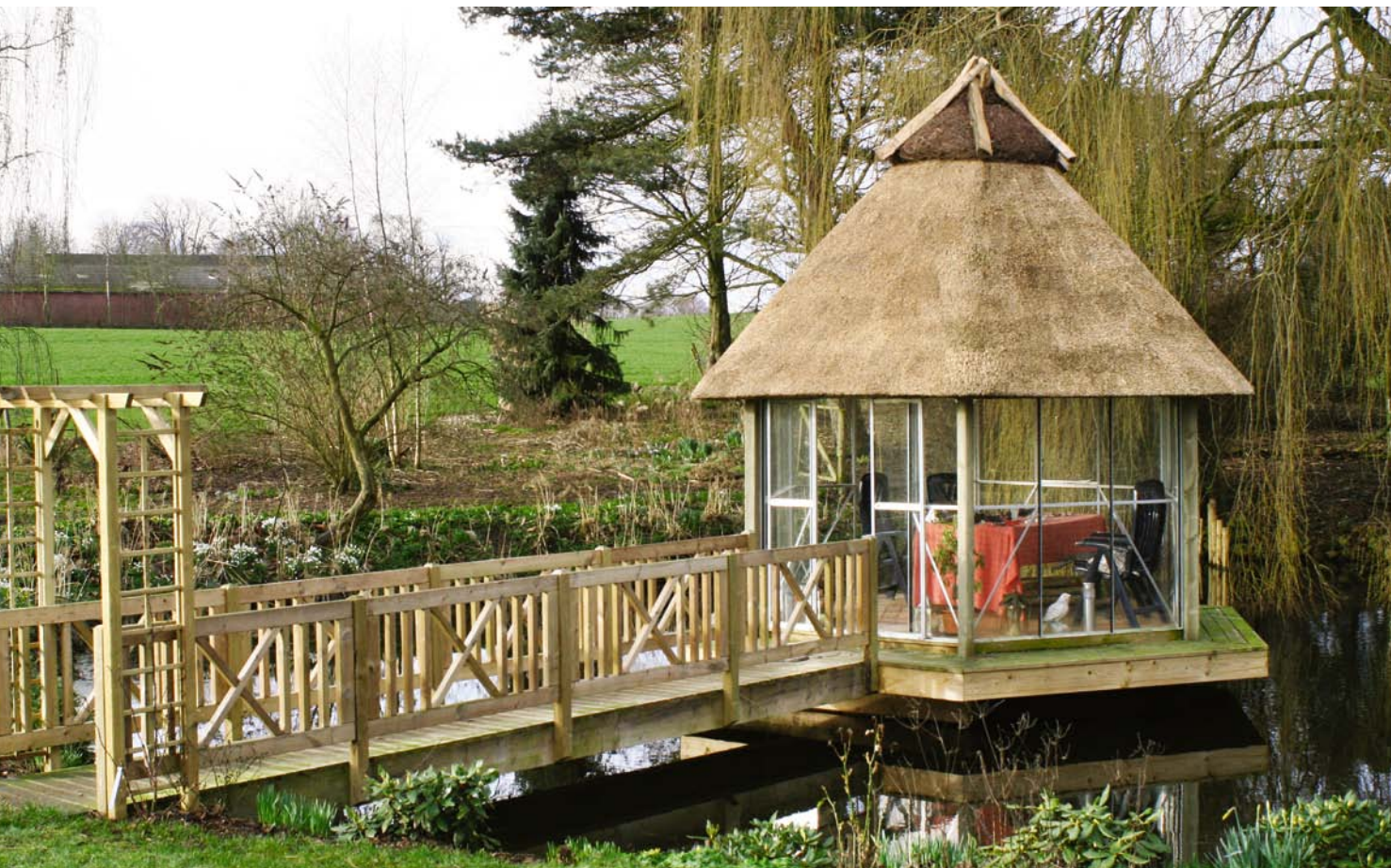
Til denne lille specialopgave er der brugt danske rør. Et tidligere drivhus er forvandlet til en hyggelig lille sø-pavillon
