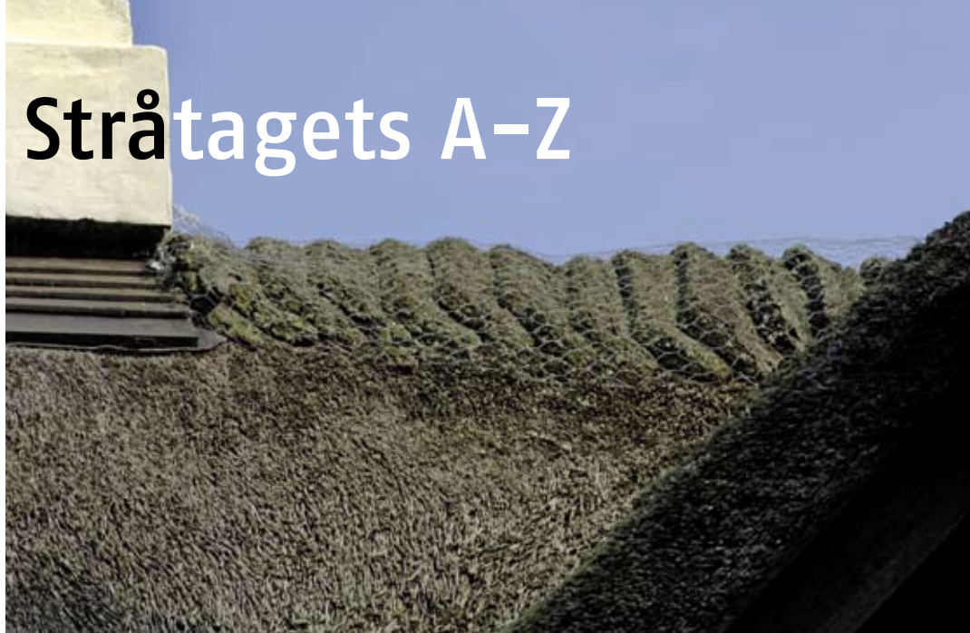
foto fra bogen: Græstørvsrygning med hønsetråd. Hus i Odder
